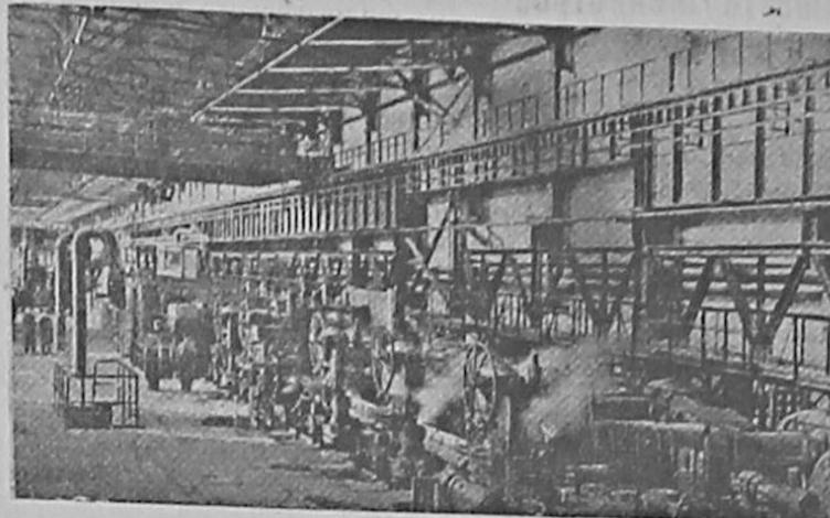
На Челябинском металлургическом заводе закончилось строительство нового прокатного стана «300». Он будет выпускать прокат в основном мелкого профиля и арматурное железо. Стан построен по последнему слову техники. Управление узлами полностью механизировано и автоматизировано. В отличие от других станов здесь построена одна большая нагревательная печь вместо двух малых.
